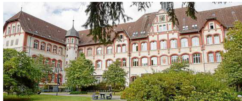
Das Altgebäude von der Rückseite aus gesehen. Dort befindet sich auch ein großer Park.
